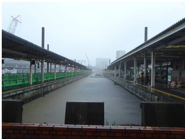
令和2年7月豪雨で水没した旧長崎駅
