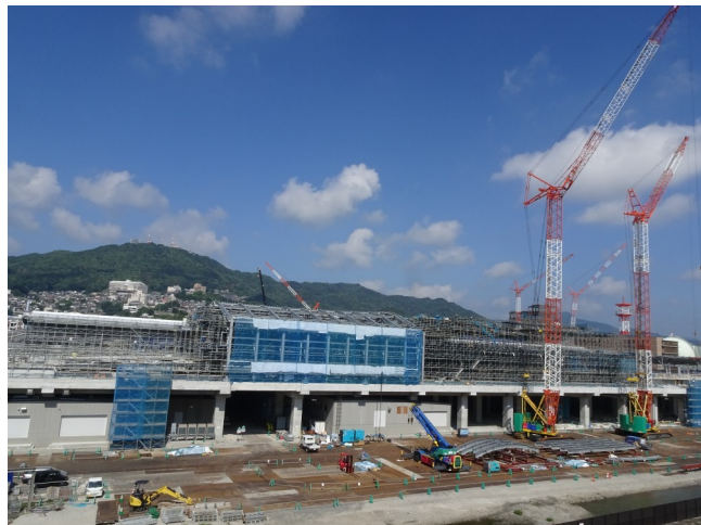
長崎駅新幹線駅工事
