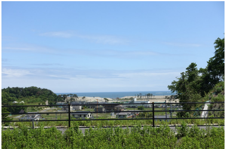
新野蒜駅から旧野蒜駅舎(三角屋根の白い建物) ・野蒜海岸・太平洋をのぞむ
