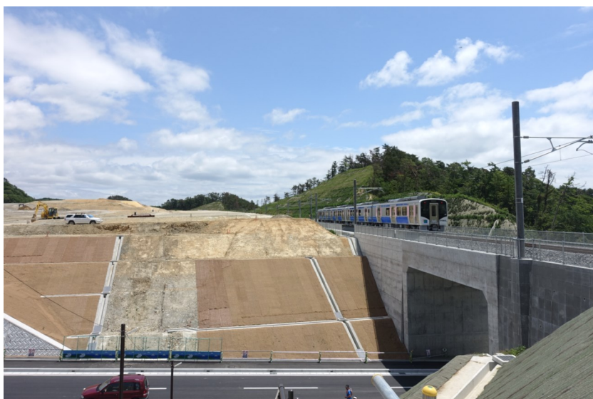
野蒜北部丘陵団地造成工事と新線
