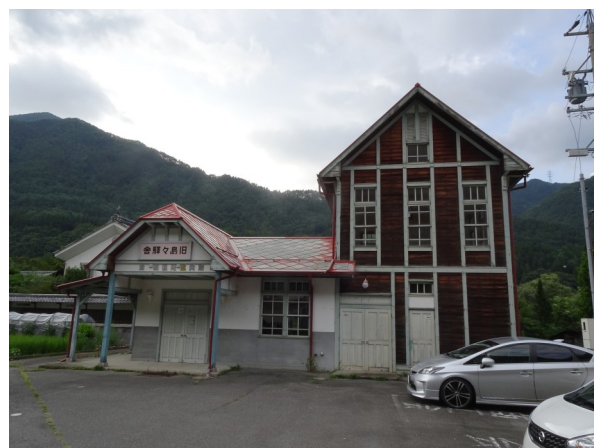
旧島々駅駅舎
