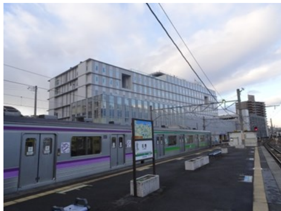
石巻駅ホームから望む石巻市立病院
