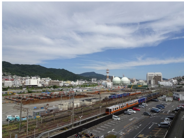
新長崎駅工事
