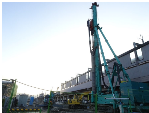
武雄温泉駅長崎新幹線工事
