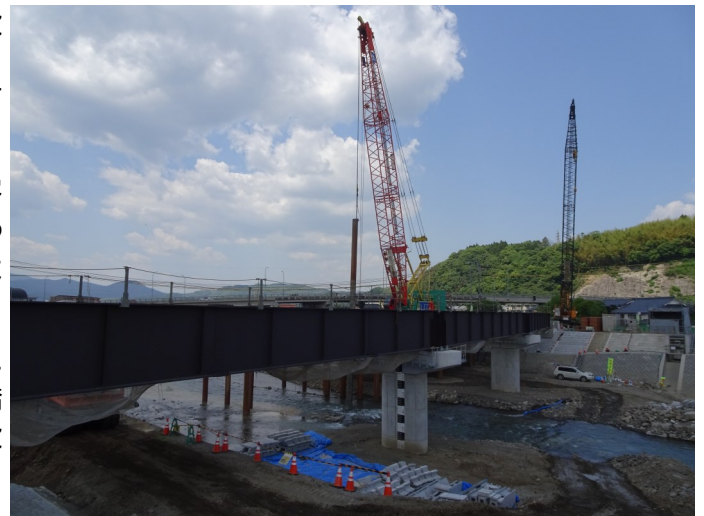
花月川橋梁工事
