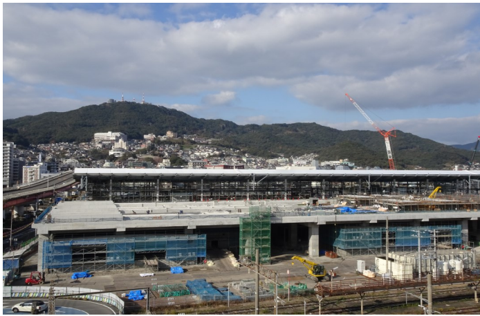
長崎駅工事 手前新幹線ホーム・奥長崎本線ホーム
